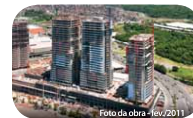
Foto da obra - fev./2011
