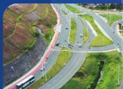
CONCLUSÃO DA LINHA AZUL, DE PATAMARES AO LOBATO
